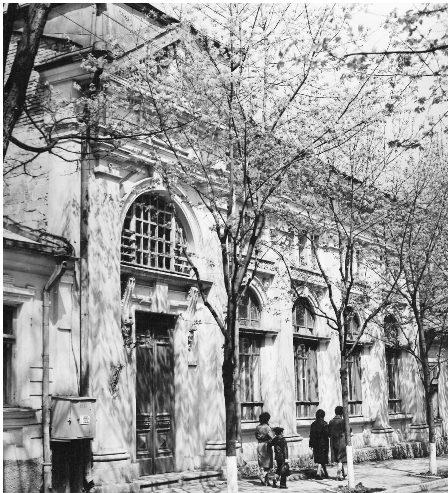
Oficiu poștal (anii 1970). Colecția Agenției de Inspectare și Restaurare a Monumentelor
