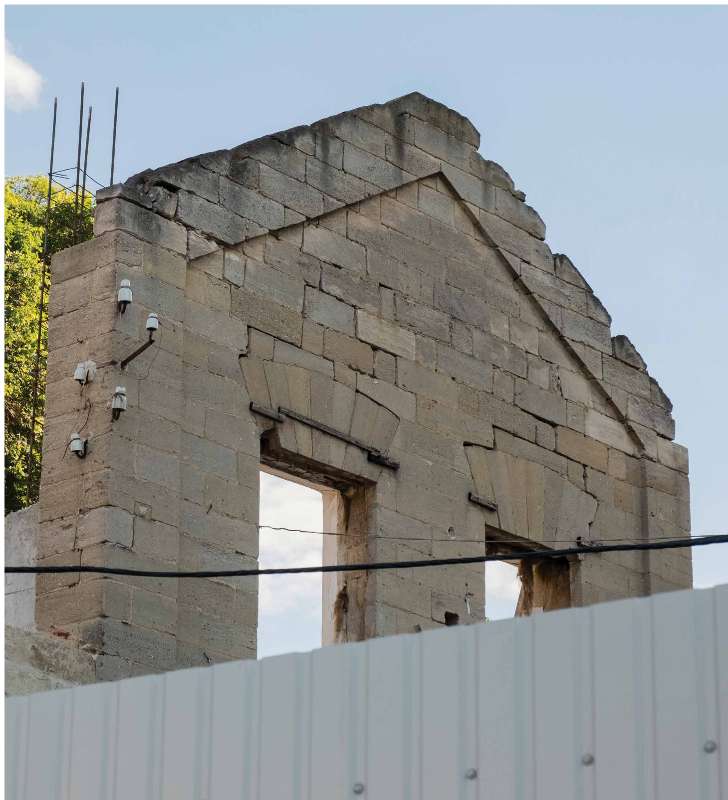
Ruina monumentului „Vilă urbană” (2024)
